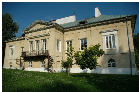
Fot.27. Pałac w Babsku (elewacja ogrodowa)
