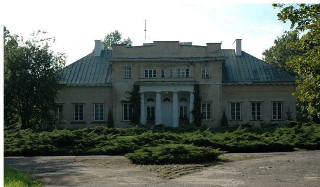
Fot.26. Pałac w Babsku (elewacja frontowa)
