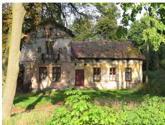
Fot.31. Dwór w Paplinie (elewacja frontowa)
