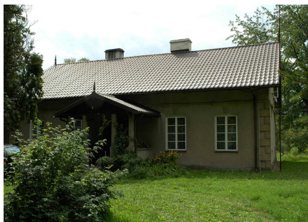
Fot.30. Dwór w Chojnacie (elewacja frontowa)
